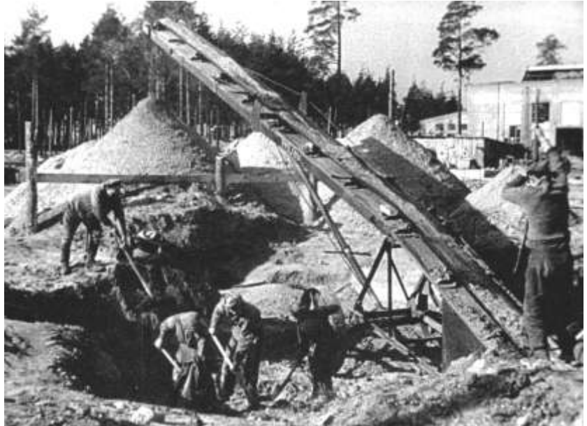
На строительстве Минского тракторного завода. 1946 г.
